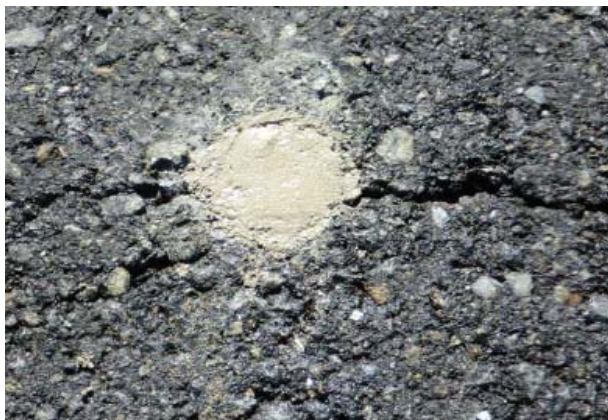
⑤コアボーリングによる孔（φ4cm）の埋め戻し
