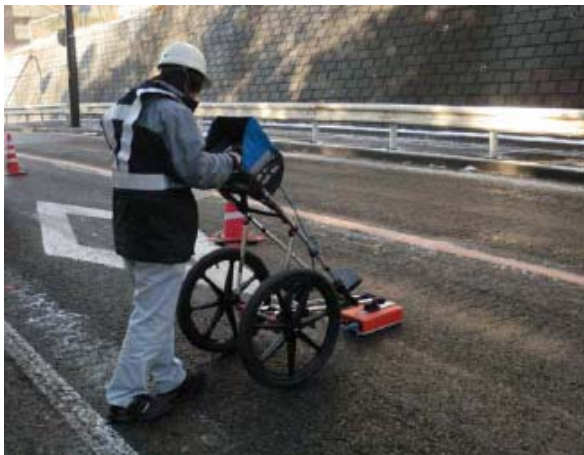
①電磁波レーダによる地下埋設物等の確認
