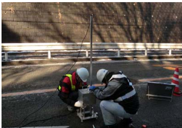
③ボアホールカメラによる舗装断面の撮影
